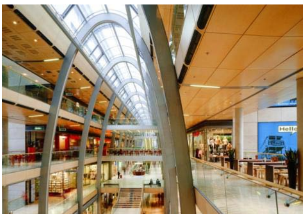
Abb. 11: Die 30.000 m 2 der 2009 fertiggestellten Europa Passage in Hamburg bieten Platz für 120 Geschäfte. Oberhalb der Passage befinden sich Büroflächen. Die markanten Stahlkonstruktionen der Passage werden durch eine F90-Brandschutzbeschichtung auf Lösemittelbasis geschützt.
