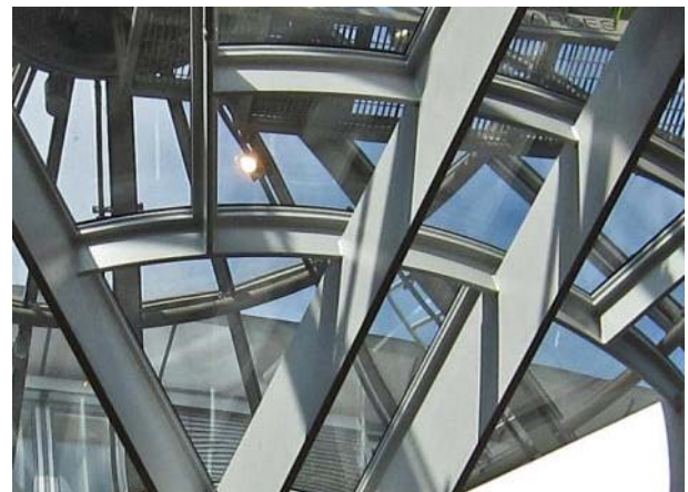
Abb. 3: Die nur wenige Millimeter dicken profilfolgend aufgetragenen Brandschutzanstriche unterstreichen die filigranen Konstruktionen der Stahlbauweise.
